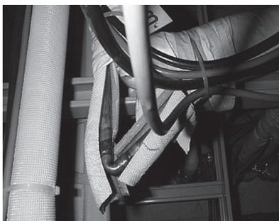
写真1 冷媒銅管の座屈事故例
