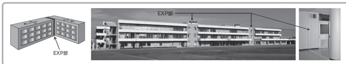
図1 学校建物の一般的な構造でエキスパンションジョイント部を示す
